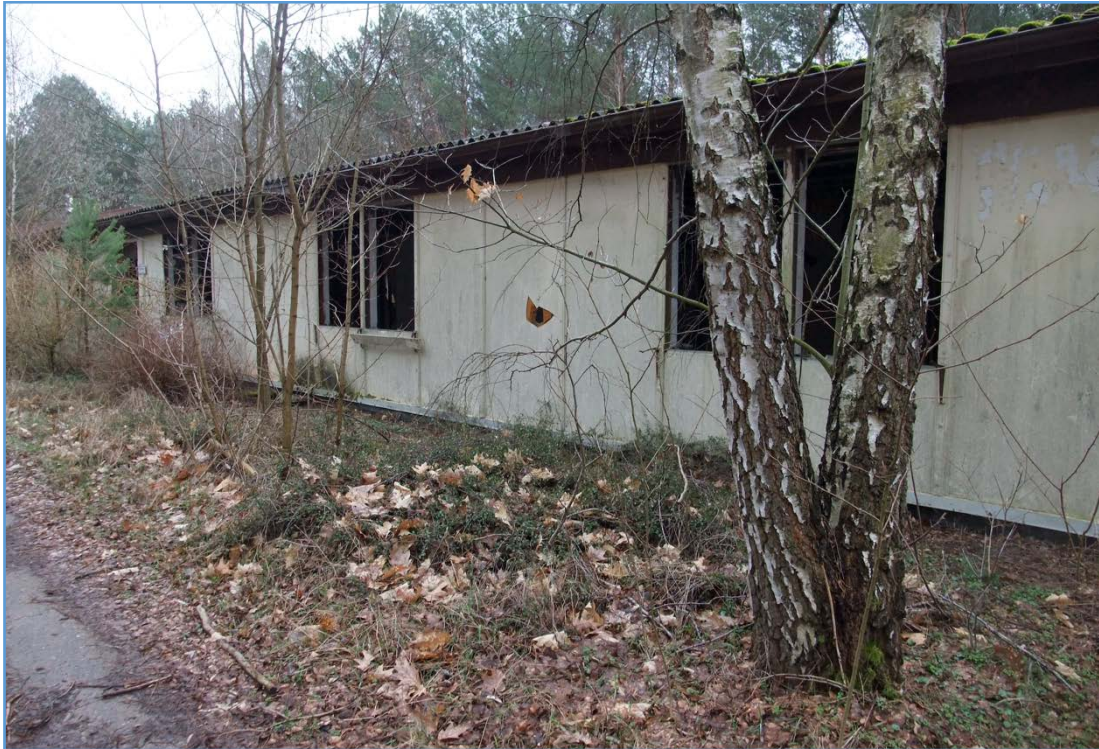
Abb. 11: ehem. Schießstand, Übergangwohnheim: Das Gebäude ist oberirdisch einfach, eher barackenähnlich gebaut. Der Keller erscheint massiv und stabil.
