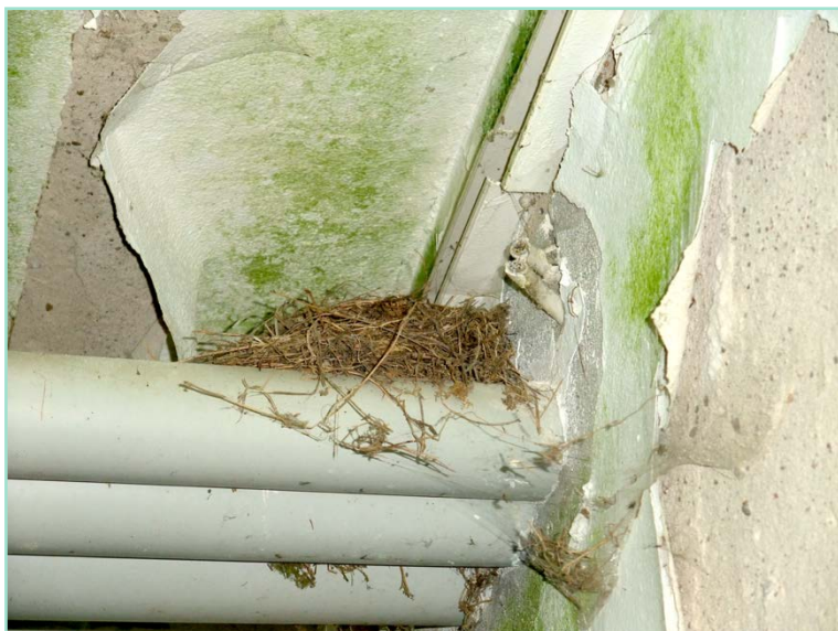
Abb. 40: Kellereingang Schießstand (Übergangwohnheim): Nistplatz, wahrscheinlich Hausrotschwanz.
