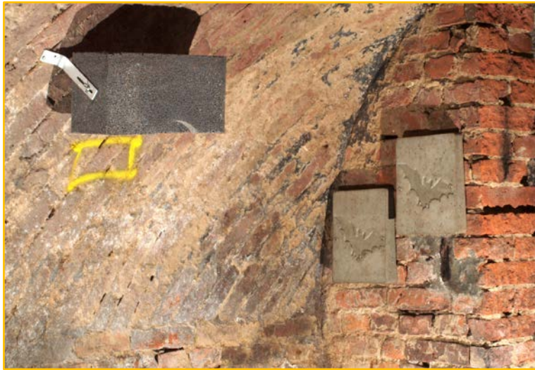
Abb. 55: Beispiel für die Anbringung von Verstecken in Fledermauswinterquartieren: Gewölbstein 1GS und Fledermauswandschale 2FE der Fa. Schwegler im Eiskeller Dahlem, Berlin.
