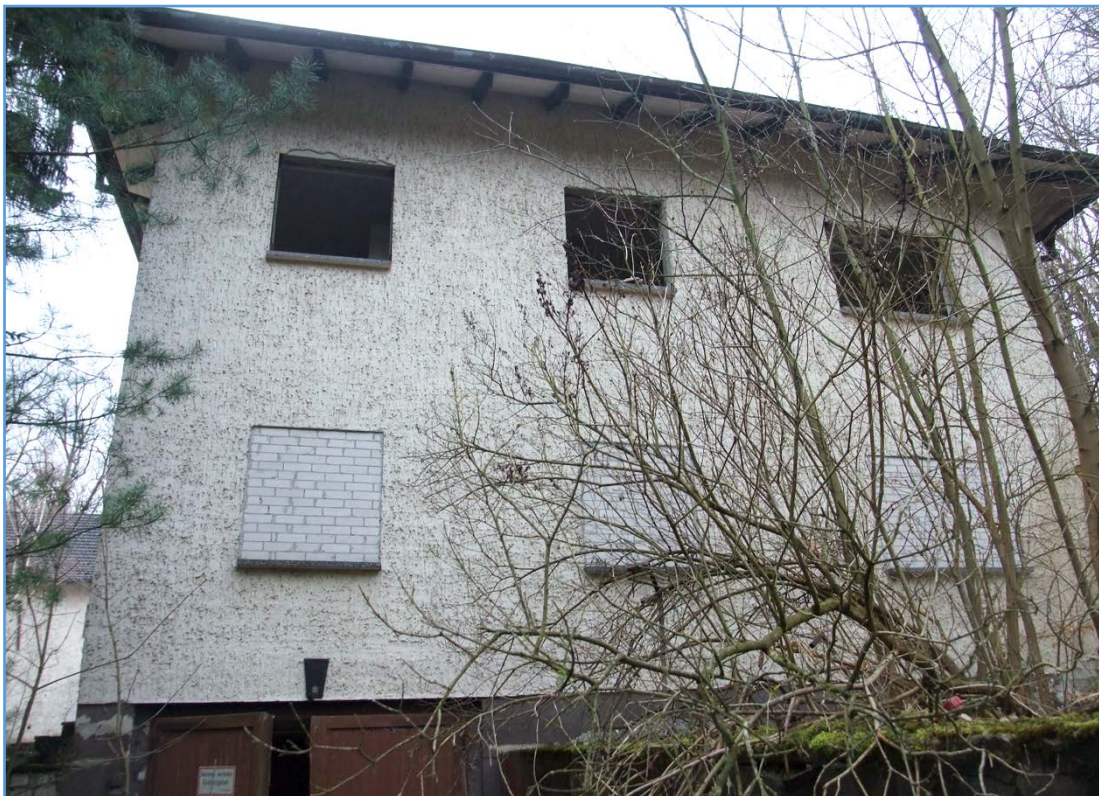
Abb. 4: Das Hauptgebäude ist für Fledermäuse frei zu befliegen und bietet geeignete Quartierbereiche.
