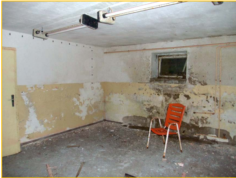
Abb. 49: Der Keller unter der ehemaligen Kegelbahn sollte erhalten und zu einem vollwertigen Fledermauswinterquartier entwickelt werden.
