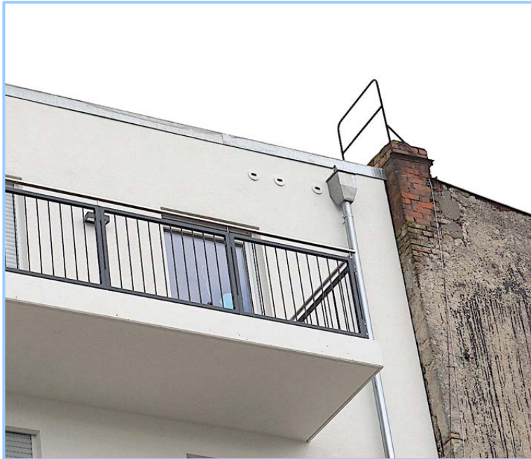
Abb. 57: Integration von einem Mauerseglerkasten 17A, dreifach in einen Neubau. Tino-Schwierzina- Str. 5 in Berlin-Heinersdorf, 2021.
