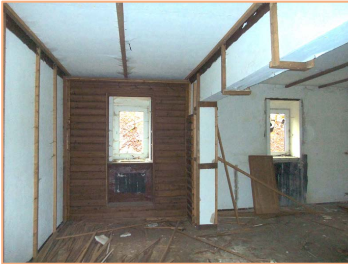
Abb. 18: Keller Schießstand / Übergangswohnheim: Nachts flogen Braune Langohren vielfach hinter die Holzverkleidung. Dort ist auch für andere Fledermausarten eine Überwinterung in uneinsehbaren Nischen möglich.
