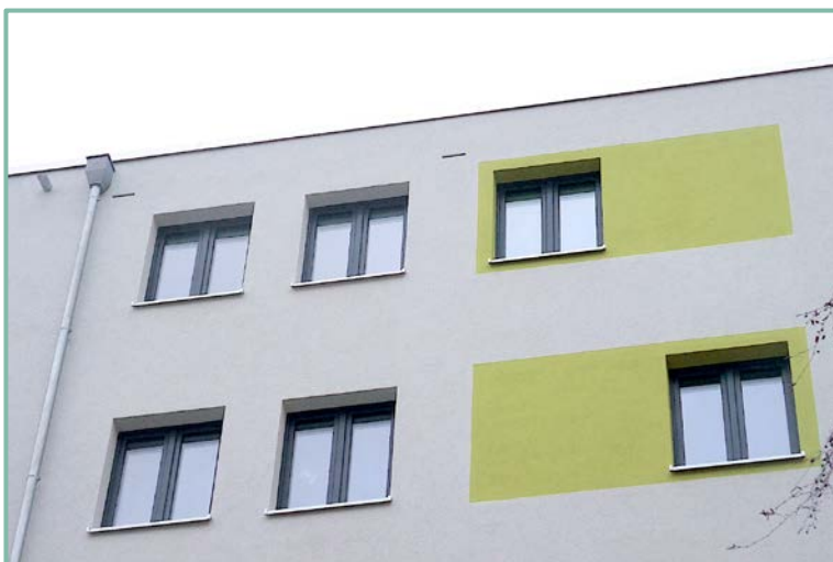
Abb. 59: Integration von Fledermaus- verstecken (Fledermauseinlaufblende 1FE) in einen Neubau. Eckertstraße 3A, 4A, 5A, Petersburger Straße 72D, 72E in Berlin-Friedrichshain, 2019.
